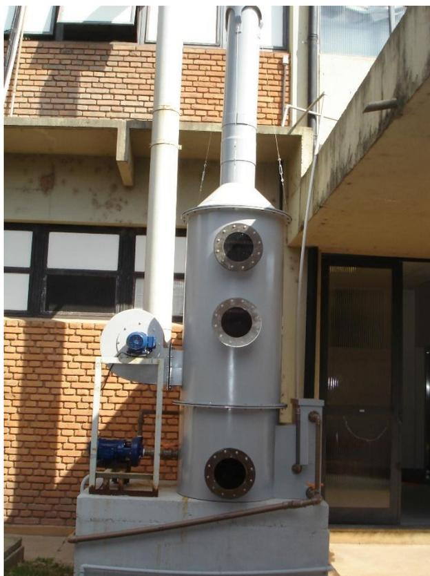
Figura 72 – Lavador de Gases para vapores ácidos do Laboratório de Nutrição Animal reformado em 2016/17.
