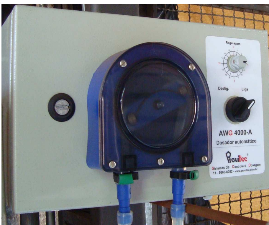
Figura 8. Imagem com detalhes da face frontal da bomba de recirculação.
