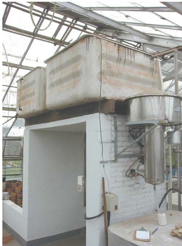
Figura 8 – Destilador de 56.000 watts, anteriormente existente no interior da Casa de Vegetação do CENA/USP.
