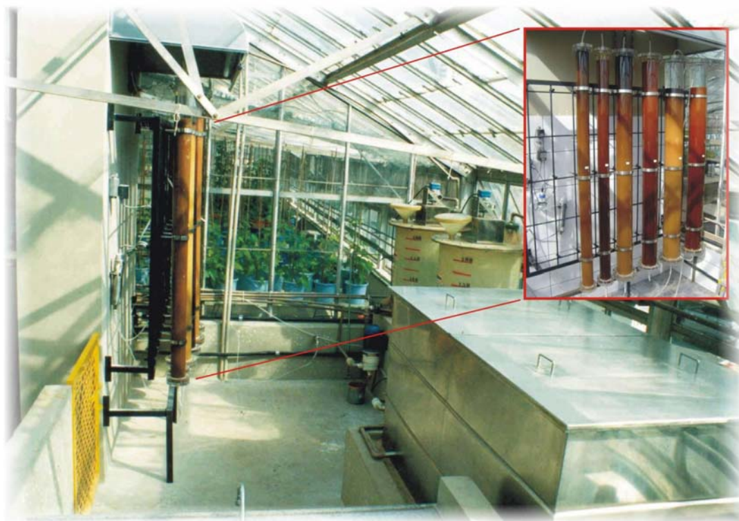
Figura 35 – Central de produção de água desionizada para fornecimento aos laboratórios de ensino e pesquisa do CENA/USP. No detalhe, as colunas contendo resinas, o esterilizador UV e o medidor de condutividade.
