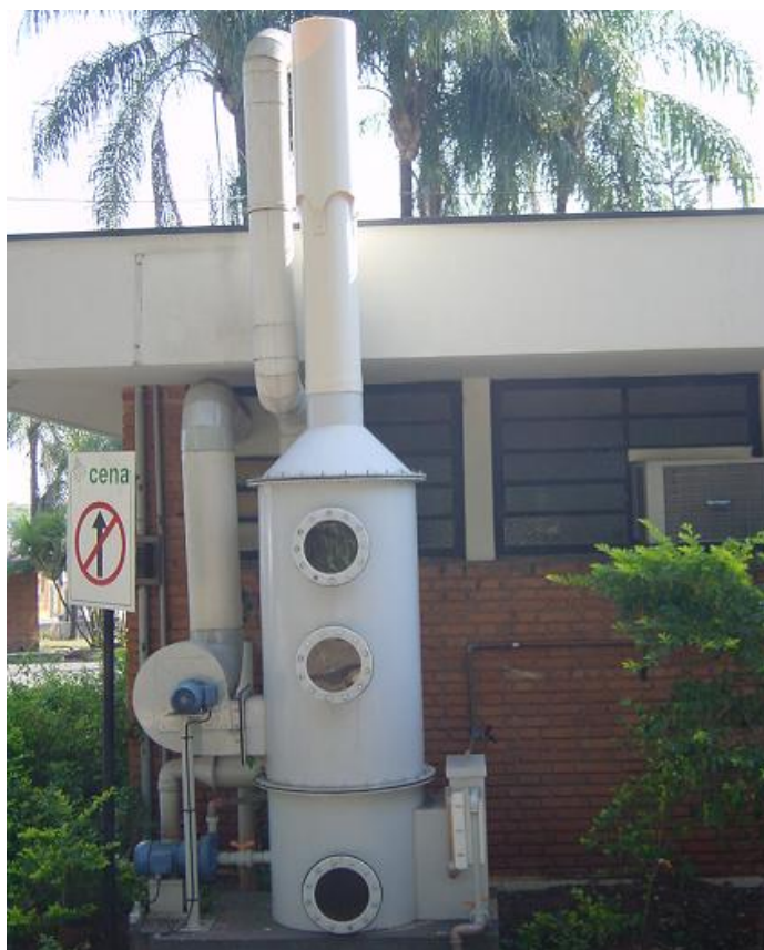
Figura 25 – Lavador de gases para tratamento de vapores ácidos, acoplado ao sistema de exaustão de capela instalada no Laboratório de Nutrição Mineral de Plantas do CENA/USP.
