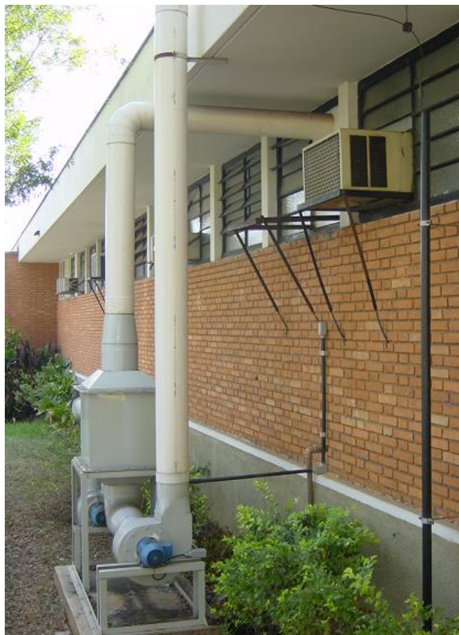
Figura 26 – Lavador de gases para tratamento de vapores orgânicos, acoplado ao sistema de exaustão de capela instalada no Laboratório de Biotecnologia Vegetal do CENA/USP.
