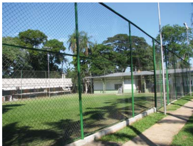
Reconstrução do alambrado do campo de futebol.
