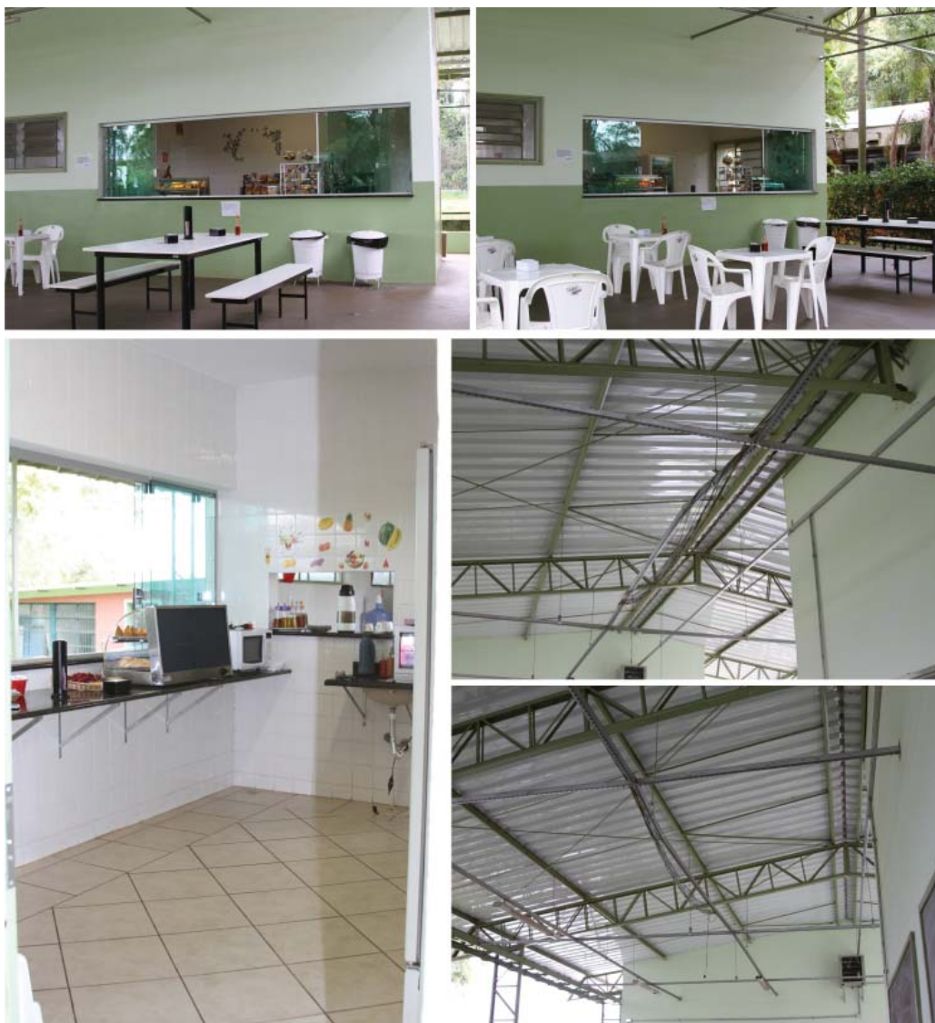
Conclusão da reforma da Cantina.
