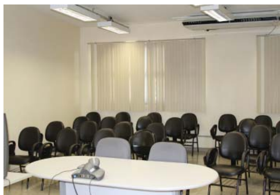
Sistema de Ar condicionado da nova Central de Aulas.
