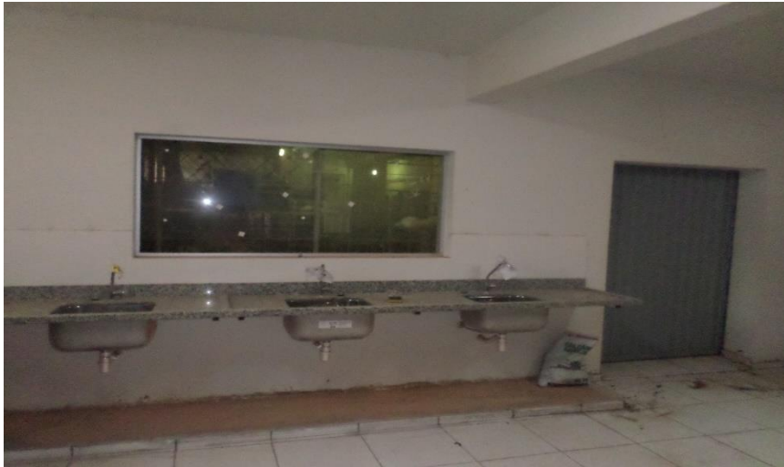
Figura 13. Detalhes da obra de reforma do Biotério (laboratório de Nutrição Animal)
