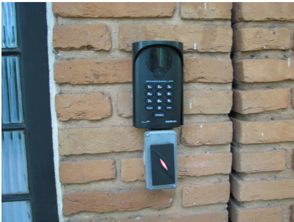
Figura 36. Detalhes do sistema de acesso eletrônico no laboratório de Física do Solo
