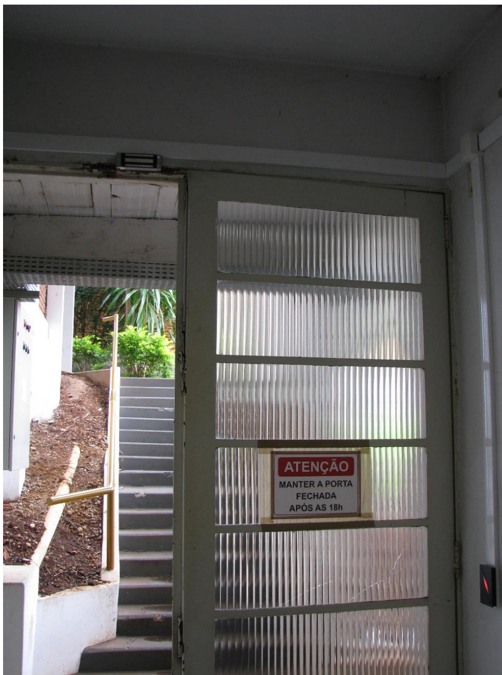
Figura 41. Sistema de acesso no prédio da administração (motorista, engenharia)
