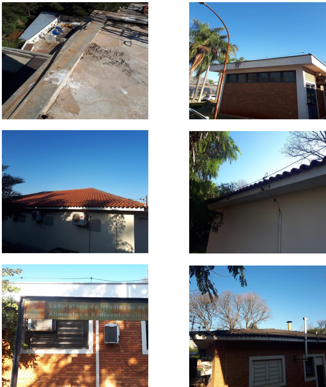
Figura 20. Detalhes do sistema de proteção contra descargas elétricas em alguns prédios do CENA/USP.
