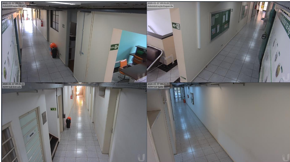
Figura 32. Detalhes de imagens do prédio da administração Central do CENA
