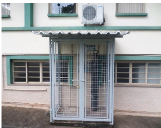
Figura 19. Detalhes dos abrigos e tubulações para adequação das linhas de GLP.
