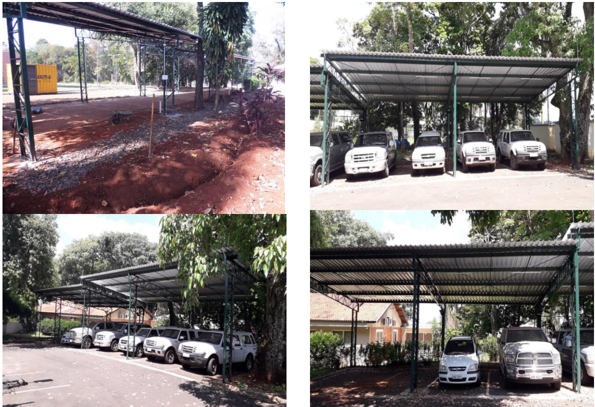
Figura 17. Detalhes da garagem
