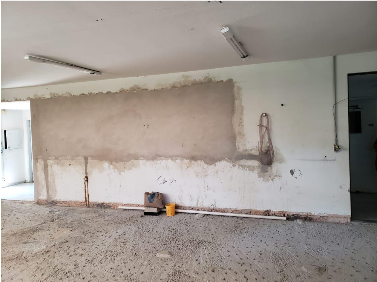
Figura 27. Detalhes do andamento da reforma do LBIS.
