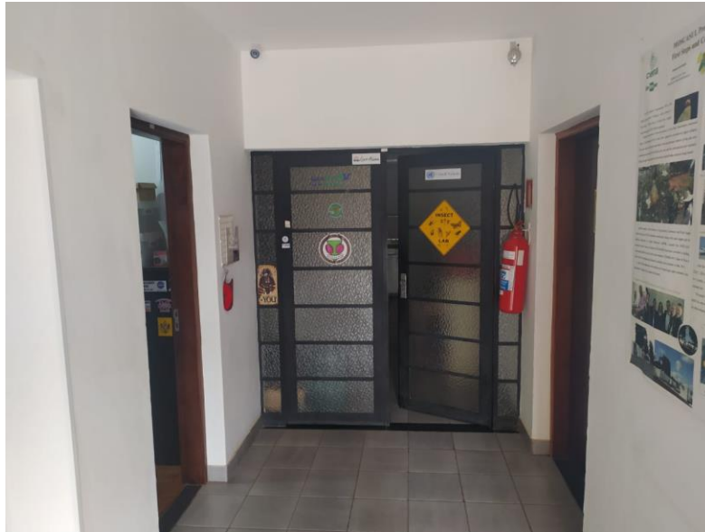
Figura 36. Detalhe da câmera de monitoramento no laboratório de Irradiação de Alimentos e Radioentomologia (localização do equipamento – área externa)
