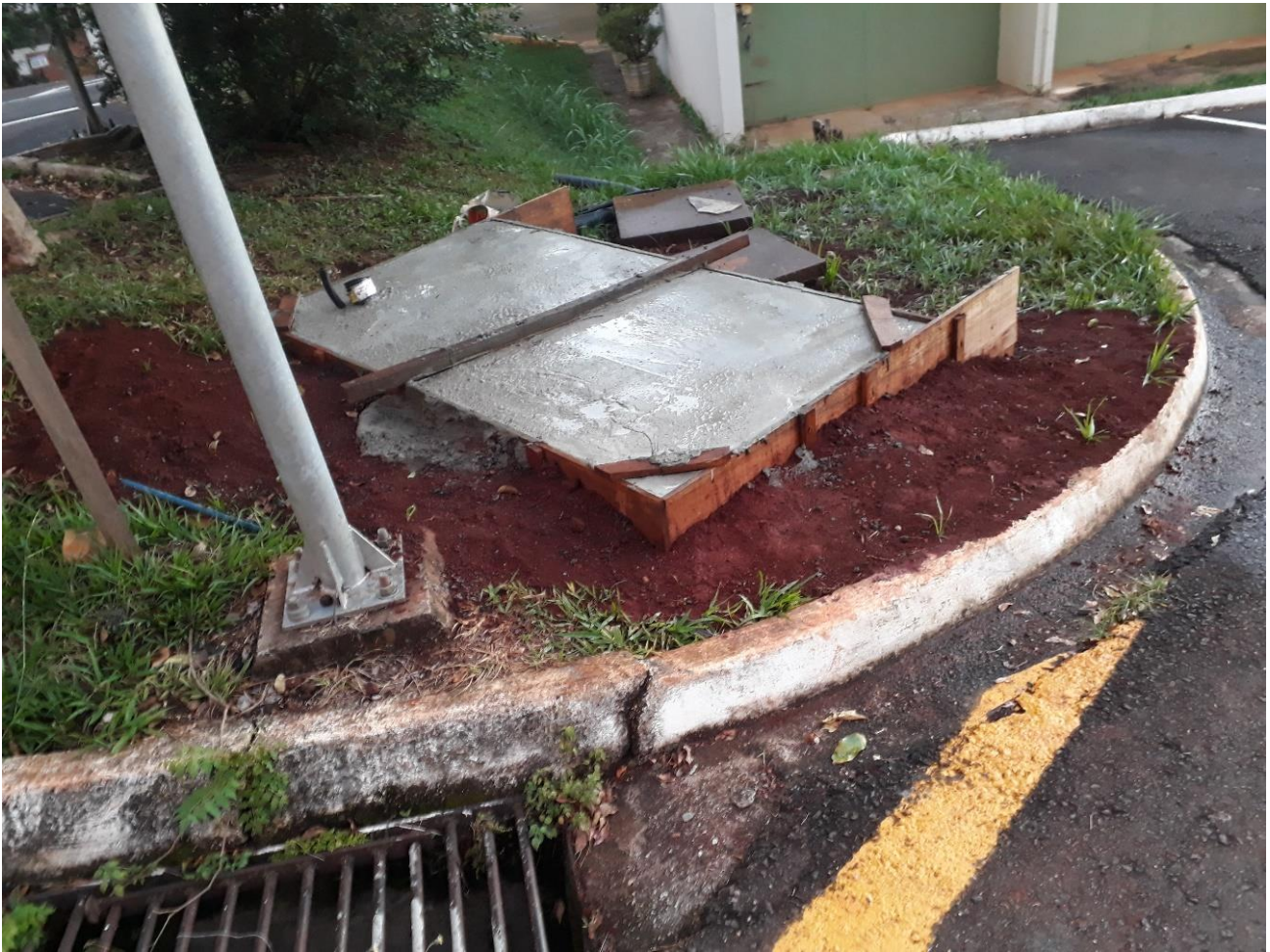
Figura 20. Base de concreto objetivando a instalação do Gerador para a Central de Aulas
