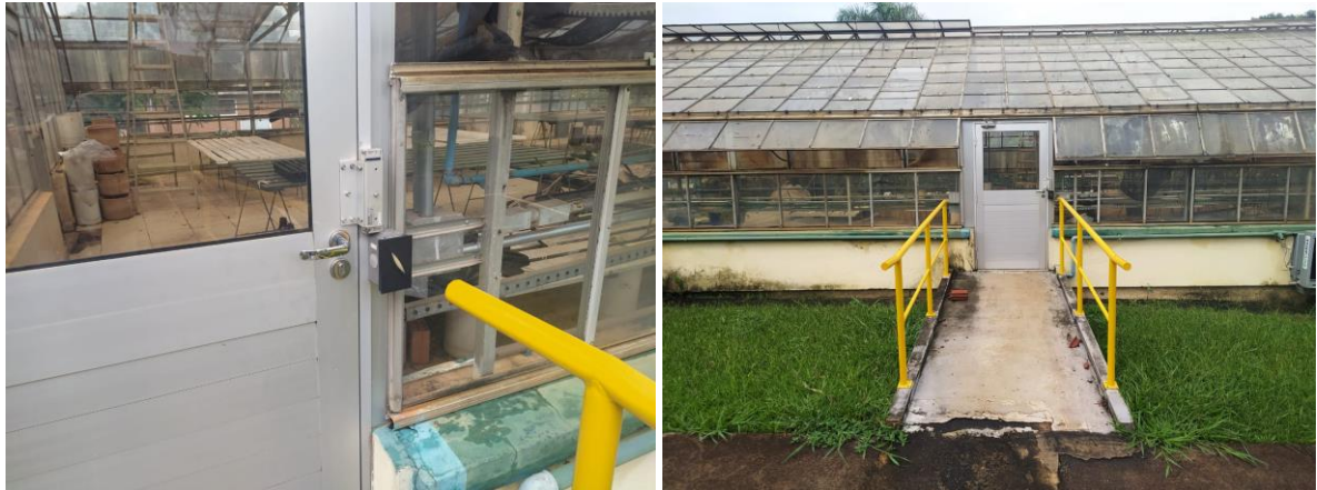
Figuras 47 a 48. Detalhes do sistema de acesso eletrônico na casa de vegetação
