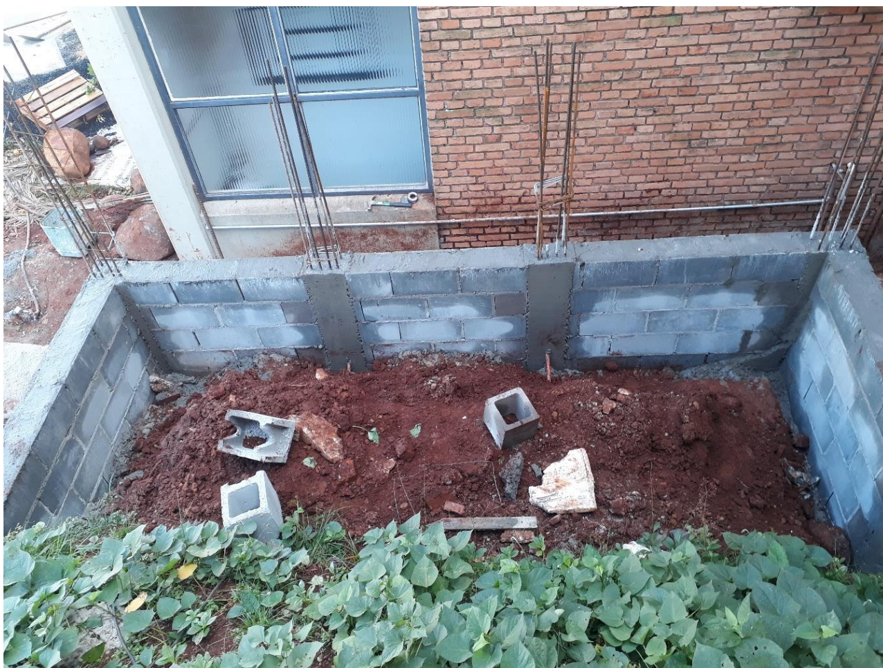
Figura 22. Detalhes da construção da base para o gerador do Biotério
