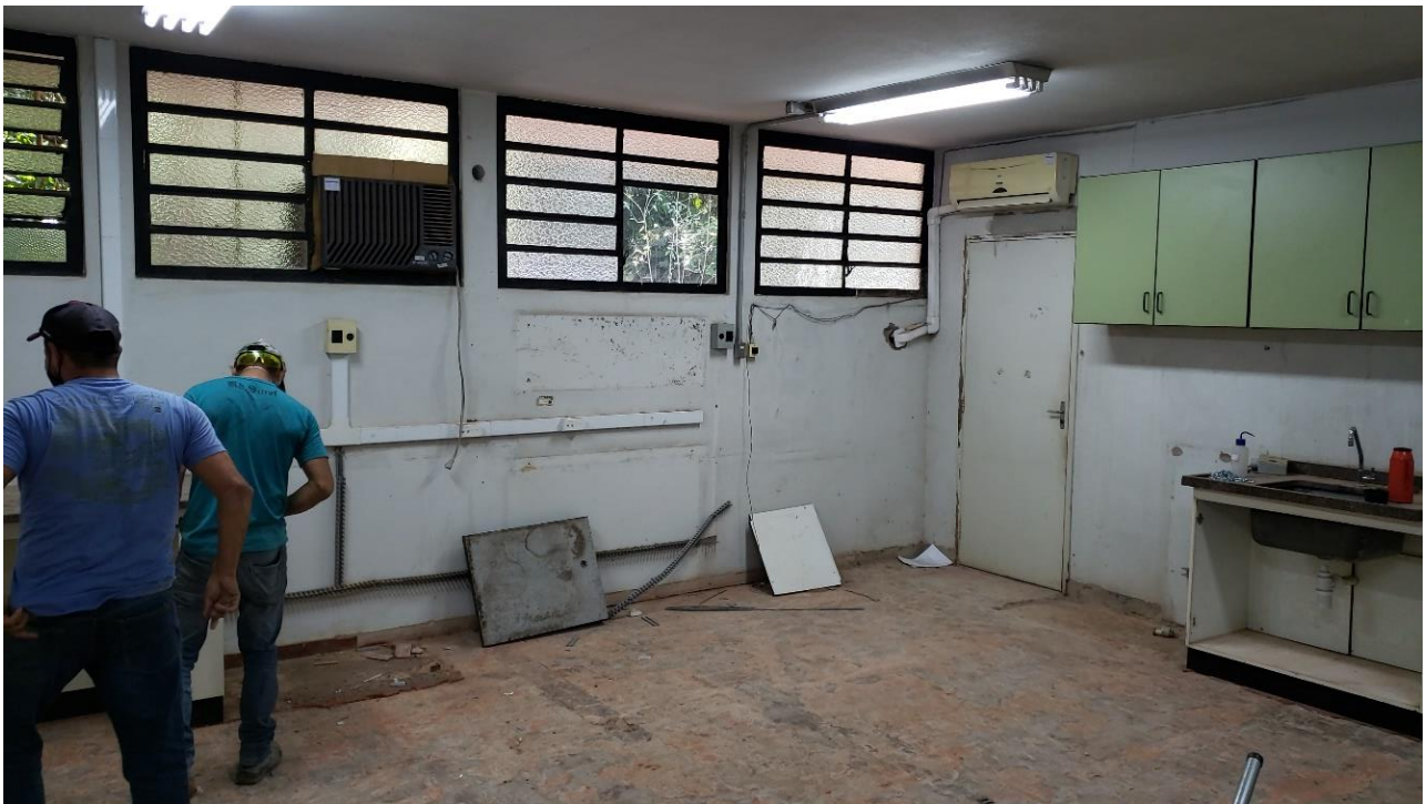
Figura 25. Detalhes do processo de demolição de parte do Laboratório de Biologia de Sistemas Regulatórios (LBIS)
