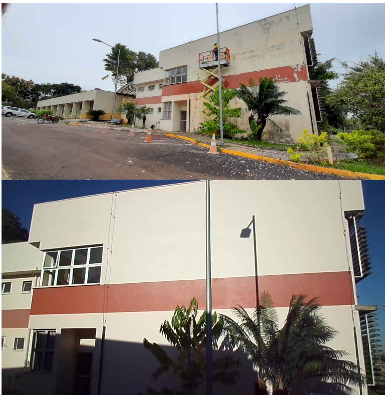
Figura 24. Detalhes da pintura externa do prédio 2 da Central de Aulas do CENA/USP
